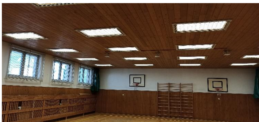
Výměna světel v tělocvičně ZŠ
